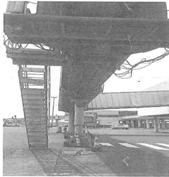
Escalier de service + façade avant de la passerelle
